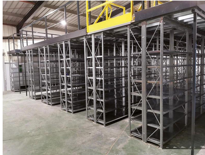
PLATEFORME SUR RAYONNAGE
